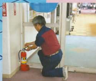
消火器安全ピン封印点検
